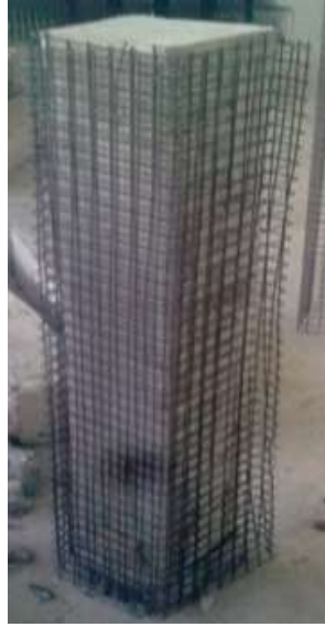
الشكل (6) الأعمدة البيتونية المسلحة بعد تغليفها بشبكات الأسلاك الملحومة
